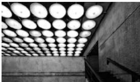
ホイットニー美術館に施されているグリッドに沿った天井照明。
